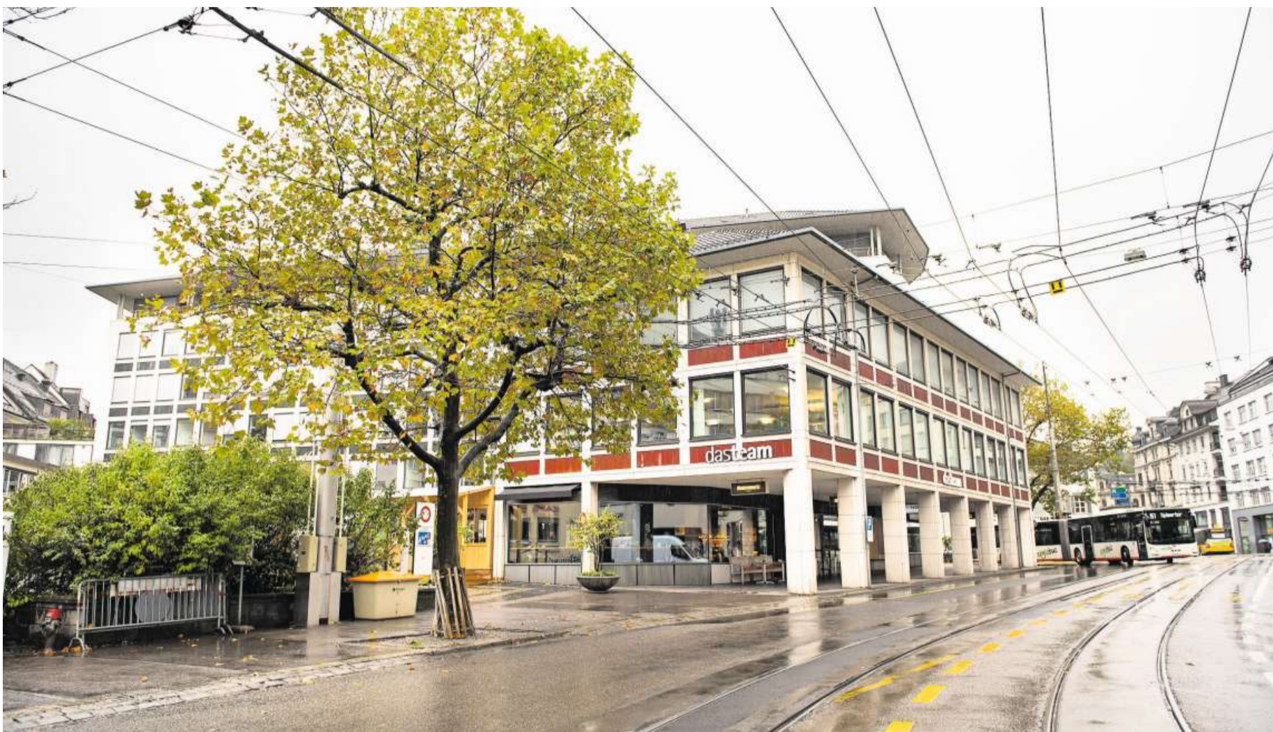
Das Union-Gebäude hinten soll stehen bleiben, der Anbau vorne soll abgerissen werden.
